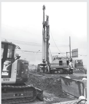
地盤層の中を掘削し、工期短縮のため、地盤改良材を注入し土を攪拌する混合処理法がとられた。
