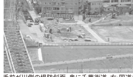
手前が川側の堤防斜面、奥に千葉街道、右・国道14号、左・JR総武線。スーパー堤防の延長は120m、幅160m、面積1.8haの盛土量約8万m 3 、区画整理を含む総事業費47億円。江戸川下流では両岸合わせ22kmがスーパー堤防の対象だが、北小岩・篠崎以外、具体的な整備計画はない。
